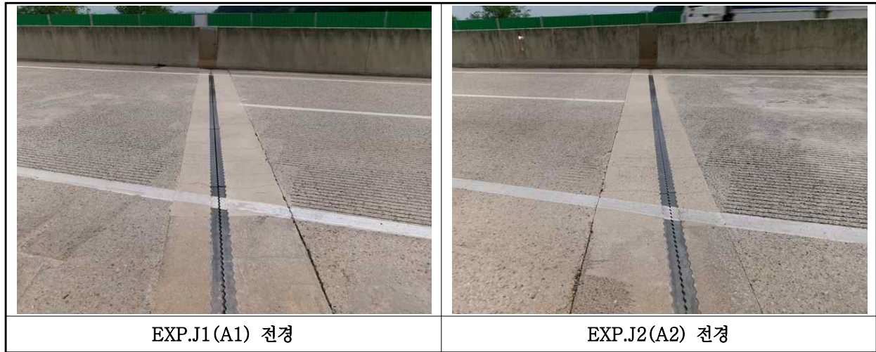
【사진 18.3.14】 신축이음장치 전경
