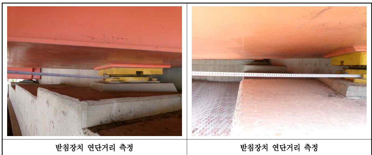
【사진 18.3.34】 교량받침장치 연단거리측정
