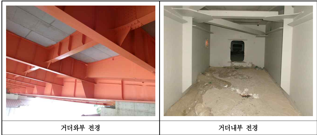
【사진 18.3.4】 거더 전경
