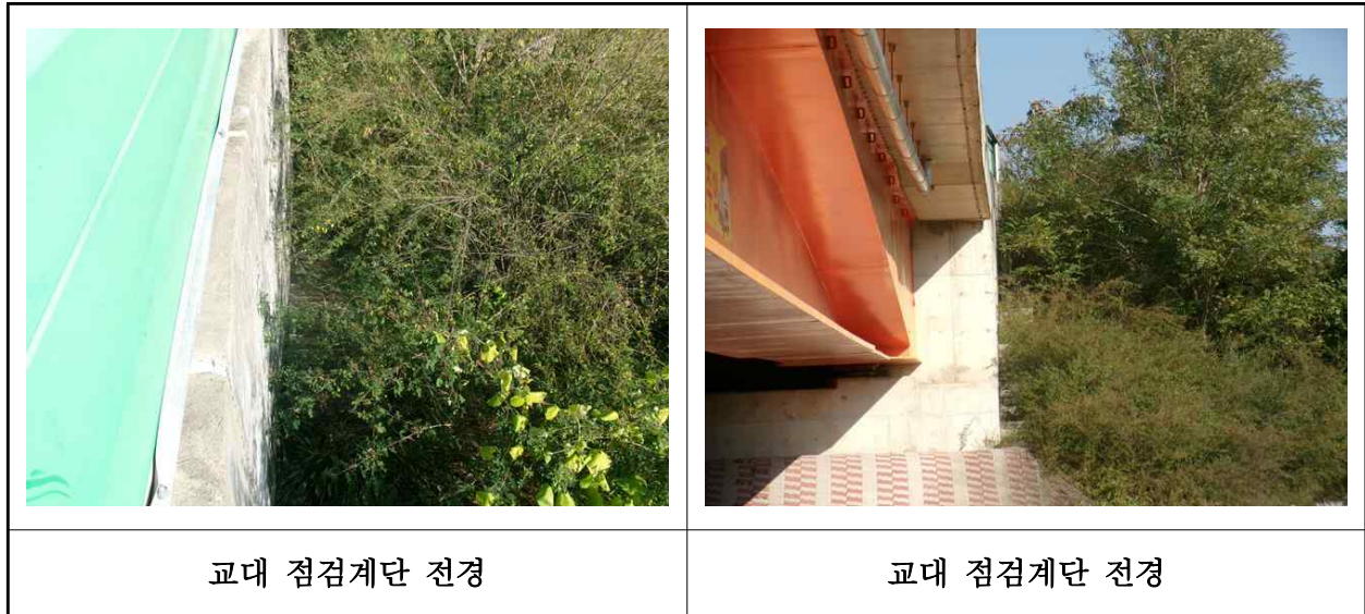
【사진 18.3.45】 교량 점검시설 전경
