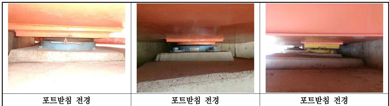
【사진 18.3.10】 교량받침 전경
