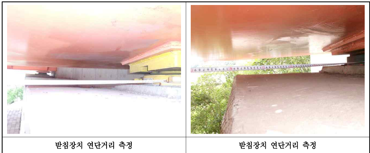
【사진 18.3.12】 교량받침장치 연단거리측정
