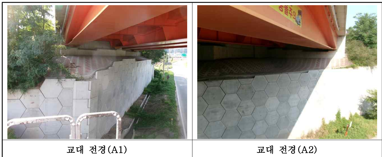
【사진 18.3.30】 교대 전경
