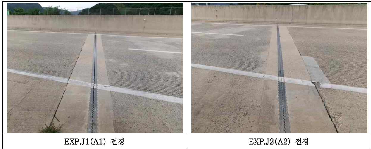
【사진 18.3.36】 신축이음장치 전경
