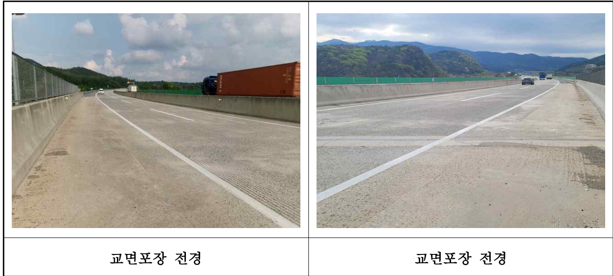
【사진 18.3.17】 교면포장 전경
