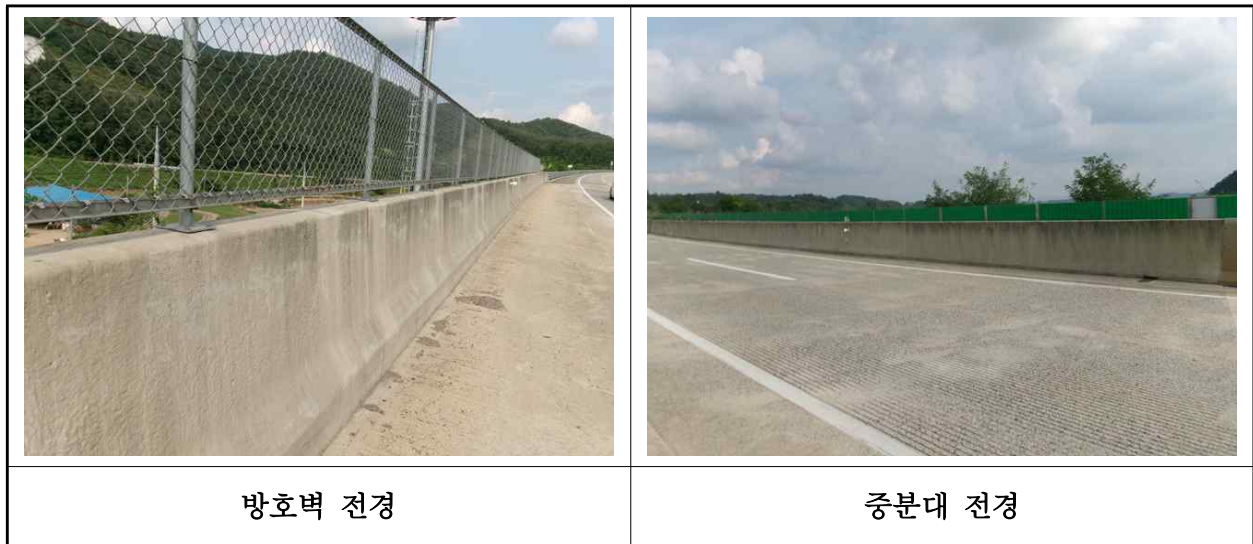
【사진 18.3.21】 방호벽 및 중앙분리대 전경
