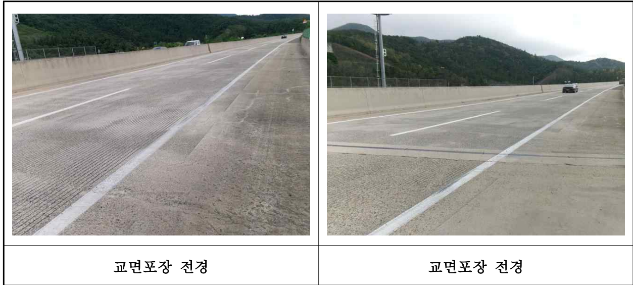
【사진 18.3.39】 교면포장 전경
