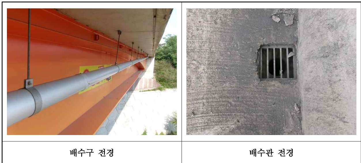
【사진 18.3.41】 배수시설 전경
