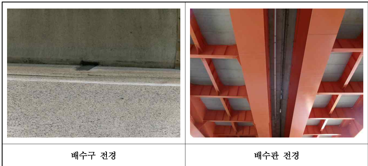
【사진 18.3.19】 배수시설 전경
